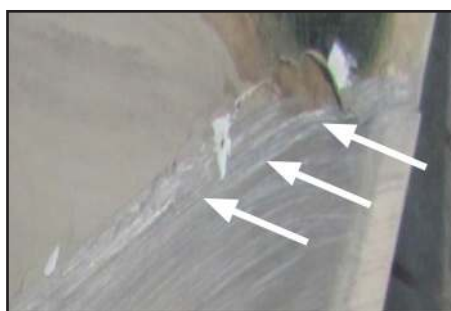
Slika 9. „Pukotine“ na desnom delu zadnjeg branika [3]
